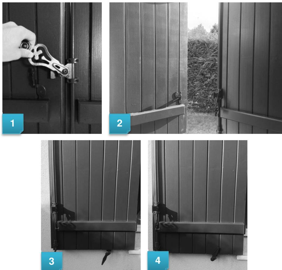
Pour la fermeture, procédez à l'inverse de l'ouverture, prenez garde à ne pas rabattre violemment vos volets afin de ne pas détériorer les vantaux sur les butées, voire d'entrechoquer les volets.
